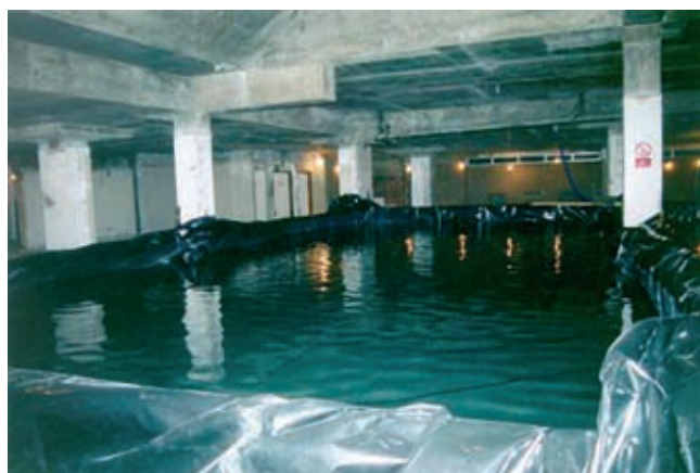
Rys. 2. Specjalna wanna dla gromadzenia wody jako obciążenia próbne [3]
