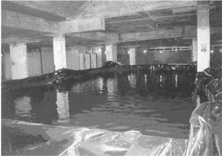
Rys. 1. Obciążenia próbne za pomocą wody w specjalnej wannie [8]
